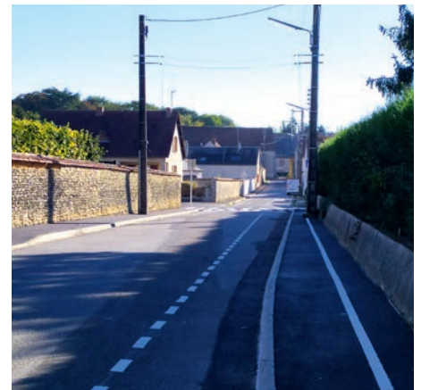
Trottoir et passage surélevé rue du Silo
