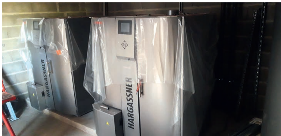
Chaudières en cours d'installation
