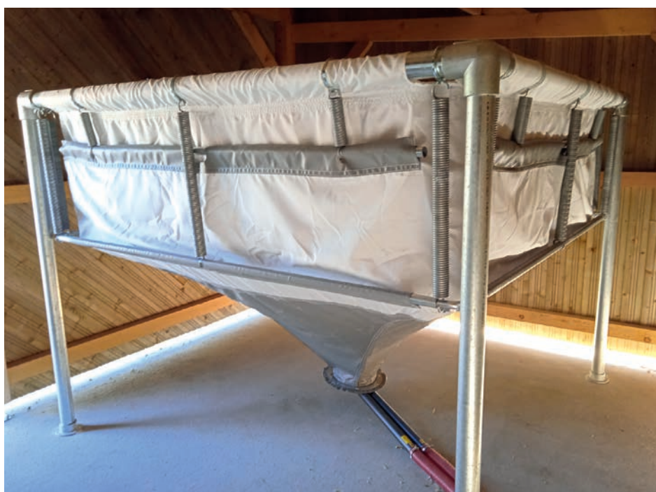
Silo de pellets
