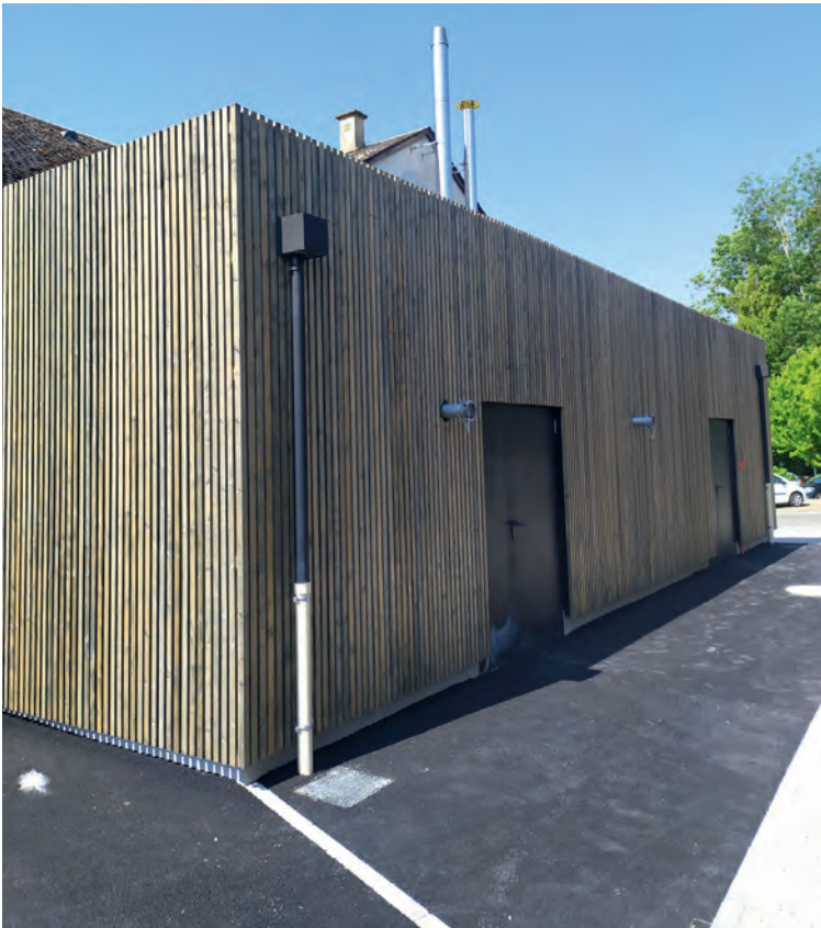
Bardage extérieur en bois de la chaufferie
